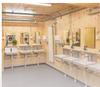
Für die WC- und Duschanlage wurde eine Holzkonstruktion erstellt.
